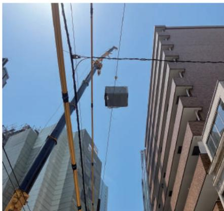
中銀カプセルタワー。解体工事では、クレーンによるカプセルの取り外しを行いました。
