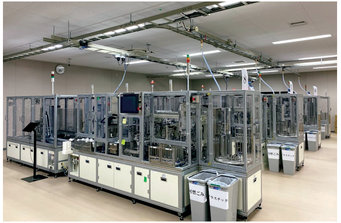
東京にある検査センター
